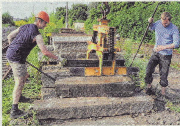
Toralf Zinner (l.) und Mathias Weber von der Bürgerinitiative „Bürgerbahnhof Plagwitz“ beim Umlagern der alten Bahnsteigkanten. Foto: mth
