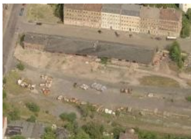
Containerabstellplatz, das war einmal:
